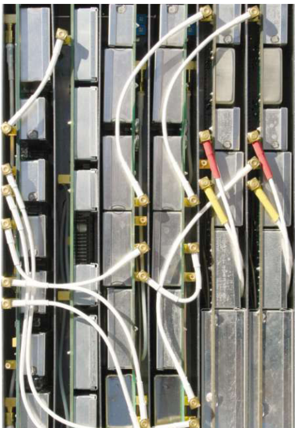
Bild 12: Alle Baugruppen sind mit abgeschirmten Leitungen und vergoldeten Steckern verbunden
